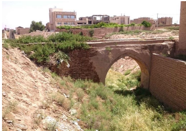
تصویر ۴: یکی از پل های آجری روی رودخانه حیدرآباد. این پل آب بر است (مأخذ: نگارنده).
