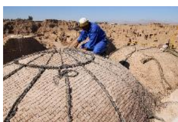
تصویر ۳۵: اجرای مش و طناب ژئوگرید بر روی طاق حجره بازار ارگ بم (مأخذ: پایگاه میراث جهانی ارگ بم، ۲۰۱۰).
