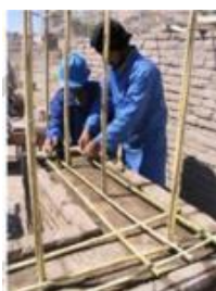
تصویر ۴۶: اجرای شبکه قائم شوره نی درون جرز دروازه دوم ارگ بم (مأخذ: فرحبخش، ۱۳۸۸).
