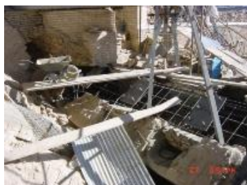
تصویر ۵: اجرای فونداسیون بتنی روی دیوار آجری در مسجد جامع همدان (مأخذ: تاج بخشیان، ۱۳۸۸).
