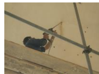
تصویر ۱۲: سوراخ کاری طاق خشتی جهت اتصال طاق به مش فلزی در خانه های کاشان (مأخذ: نگارندگان).
