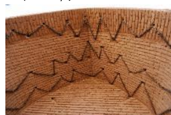
تصویر ۳۶: اجرای طناب ژئوگرید در زیر طاق حجره بازار ارگ بم (مأخذ: پایگاه میراث جهانی ارگ بم، ۲۰۱۰).
