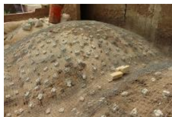
تصویر ۱۰: اجرای مش گالوانیزه با لقمه های گچی بر روی طاق خشتی در خانه منوچهری کاشان (مأخذ: نگارندگان).
