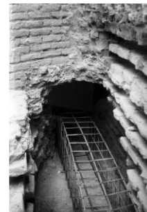
تصویر ۹: اجرای رینگ بتن مسلح در گنبد سلطانیه (مأخذ:
