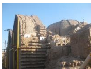
تصویر ۳۴: اجرای طناب ژئوگرید بر روی تویزه حجره بازار بم (مأخذ: پایگاه میراث جهانی ارگ بم، ۲۰۱۰).
