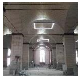
تصویر ۴۱: اجرای کمربند و کش فلزی در کارخانه درخشان (مآخذ: عزیزی و دیگران: ۱۴۰۲).
