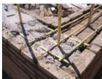
تصویر ۴۵: اجرای شناژ ماسه آهکی در دروازه دوم ارگ بم (مأخذ: فرحبخش، ۱۳۸۸).
