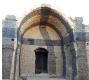
تصویر ۲۵: اجرای باریکه‌های مش ژئوگرید در خانه روستایی اصفهک (مآخذ: پارسی و منصور، ۱۳۹۵).
