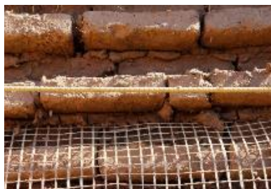
تصویر ۳۹: اجرای مش FRP در بازسازی خانه ارگ بم (مآخذ: پایگاه میراث جهانی ارگ بم، ۲۰۰۹).
