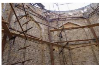
تصویر ۲: طرح قاب فلزی نگهدارنده برج خرقان (مأخذ: پارسایی و دیگران، ۱۳۹۶)
