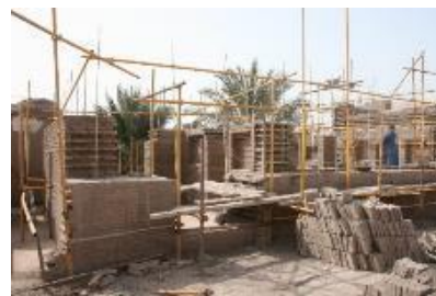
تصویر ۴۰: اجرای المان‌های قائم با FRP در بازسازی خانه ارگ بم (مآخذ: پایگاه میراث جهانی ارگ بم، ۲۰۰۹).
