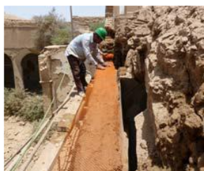
تصویر ۳۳: اجرای مش پلاستیکی درون ملات خانه طبایی اردکان (مأخذ: CRAteree, 2010).
