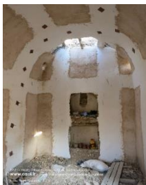
تصویر ۲۶: اجرای صفحات فلزی در اصفهک (مآخذ: پارسی و منصور، ۱۳۹۵).
