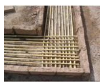
تصویر ۴۷: اجرای شبکه افقی شوره نی درون جرز دروازه دوم ارگ بم (مأخذ: فرحبخش، ۱۳۸۸).
