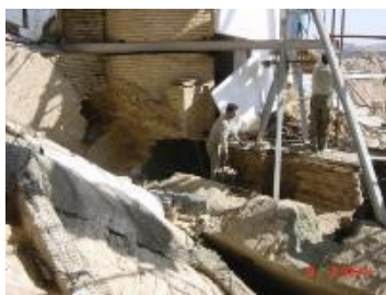
تصویر ۴: روجوب کردن مناره جهت اجرای شناژ بتنی در مسجد جامع همدان (مأخذ: تاج بخشیان، ۱۳۸۸).
