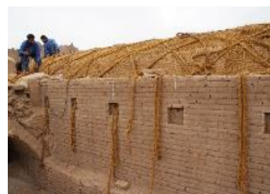
تصویر ۱۵: مهار طناب‌های سازو طاق تصویر ۱۳: اجرای طناب سازو در زیر تصویر ۱۴: اجرای مش و طناب انبار گوشه خانه سیستانی ارگ بم طاق انبار گوشه خانه سیستانی ارگ سازو بر روی طاق انبار گوشه خانه سیستانی ارگ بم (مأخذ: پایگاه میراث جهانی ارگ بم، ۲۰۰۹). (مأخذ: پایگاه میراث جهانی ارگ بم (مأخذ: پایگاه میراث جهانی ارگ بم، ۲۰۰۹). (مأخذ: پایگاه میراث جهانی ارگ بم، ۲۰۰۹).
