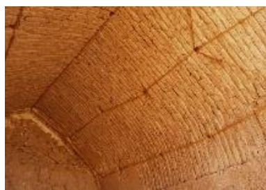
تصویر ۱۵: مهار طناب‌های سازو طاق تصویر ۱۳: اجرای طناب سازو در زیر تصویر ۱۴: اجرای مش و طناب انبار گوشه خانه سیستانی ارگ بم طاق انبار گوشه خانه سیستانی ارگ سازو بر روی طاق انبار گوشه خانه سیستانی ارگ بم (مأخذ: پایگاه میراث جهانی ارگ بم، ۲۰۰۹). (مأخذ: پایگاه میراث جهانی ارگ بم (مأخذ: پایگاه میراث جهانی ارگ بم، ۲۰۰۹). (مأخذ: پایگاه میراث جهانی ارگ بم، ۲۰۰۹).
