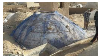
تصویر ۴۳: اجرای مش پلاستیکی و سازو بر روی طاق‌های کارخانه درخشان (مآخذ: عزیزی و دیگران: ۱۴۰۲).
