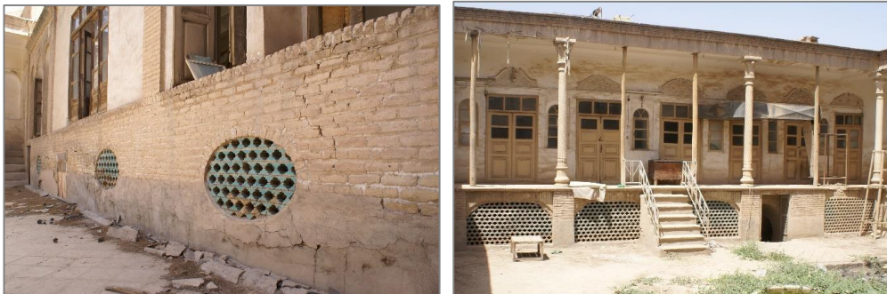
تصویر ۲۰: استفاده از شبک آجر لعابی در منفذهای زیرزمین های خانه لاجوردی زاده قم
