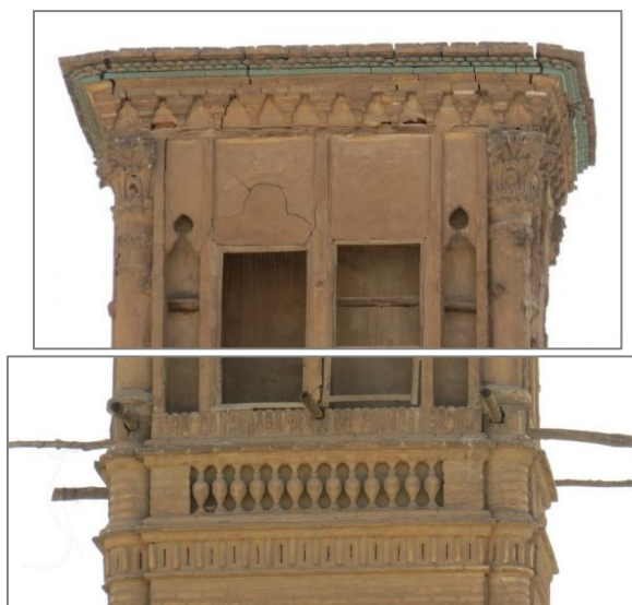
تصویر ۱۲: آرایه‌های آجری و گچی کلاله و ساقه بادگیر ضلع شمالی خانه رهبری در قم
