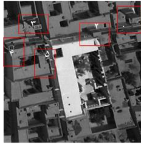
تصویر ۷: عکس هوایی سال ۱۳۳۵ محدوده هم‌جواری خانه پنج‌دري ۱: بادگیر موجود خانه علی اردکانی ۲: بادگیر تخریب‌شده خانه علی اردکانی ۳ و ۴ و ۵: دیگر بادگیرهای تخریب‌شده در هم‌جواری بنا
