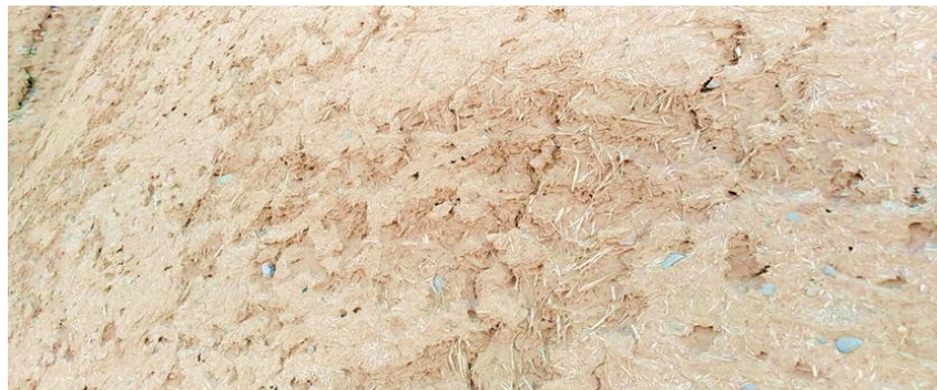
تصویر ۸: فرسایش و تخریب نسبی در بخش‌های مختلف لایه کاهگل (مأخذ: نگارنده)
