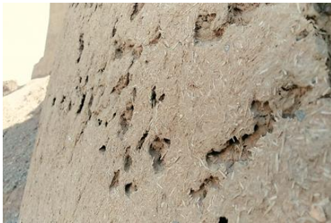
تصویر ۲: (الف) انتقال خاک در محل ورودی لانه حشره روی زمین (ب) ورودی‌های متعدد در بدنه تاریخی بدون تجمع خاک (مأخذ: نگارنده)
