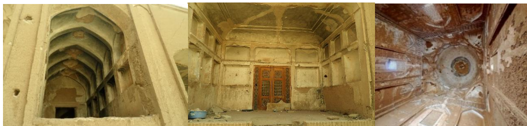
تصاویر ۳۵ تا ۳۷: قاب‌بندی بشن گنبدخانه از ویژگی‌های مدارس این دوران است.
