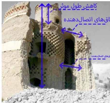
تصویر ۱۲: کاهش طول مؤثر از طریق اتصال حلقه داخلی به بیرونی در کبوترخانه خمین (jazebeha.com)
