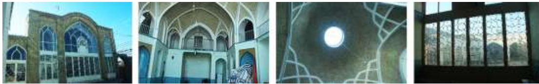
تصویر ۶ به ترتیب از راست به چپ: تکیه مقابل حسینیه؛ کاربردی و نورگیر گنبد؛ غرفه‌های همکف و فوقانی؛ نمای شمالی و ورودی اصلی (مأخذ: نگارندگان)
