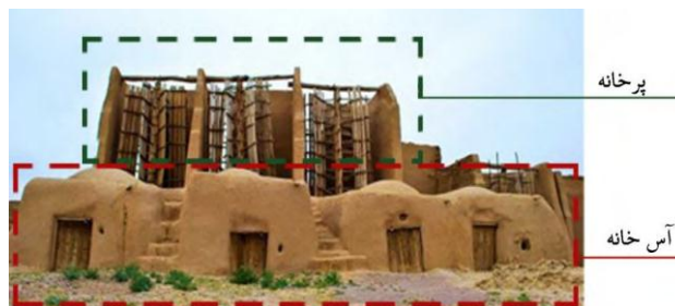
تصویر ۶- ساختمان و اجزای تشکیل‌دهنده آسباد، مأخذ: رستگار و آزاد، ۱۳۹۴
