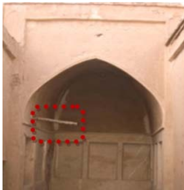
تصویر ۳- آثار کارگاه برک در ایوان خانه‌های کوچک
