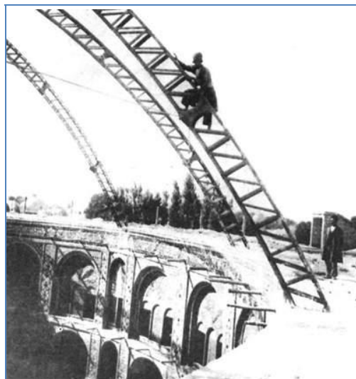
تصویر ۹- تصویر خرپای فلزی تکیه دولت (ماخذ: فرهمند، ۱۳۹۶)
