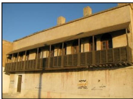
شکل ۲. شناسیرهای چوبی در نمای غربی یک ساختمان در بوشهر (مآخذ: نگارنده)
