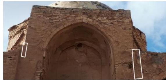
تصویر ۳۲: عدم اتصال دو بخش و الحاقی بودن ایوان کوچک آرامگاه میرمطهر.
