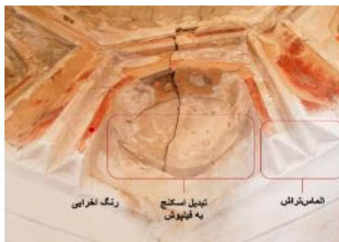
تصویر ۴۳: تزیینات مربوط به گوشه‌سازی و پوشش آرامگاه باباتوکل.
