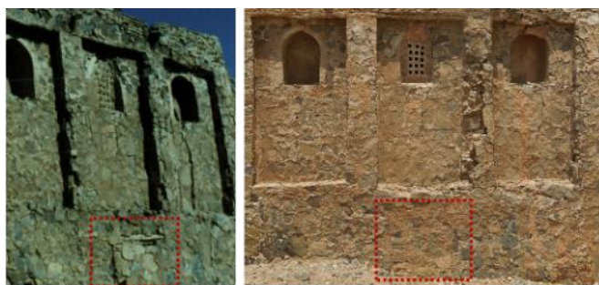
قبل از مرمت و مشخص بودن نعل درگاه بازشو
