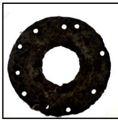
تصویر ۱۹. در پوش مجرای فشار تنوره آسیاب ریگاره که در بر روی تنبوشه انتهای استوانه تجمع آب، این مجرا قرار می‌گیرد.
