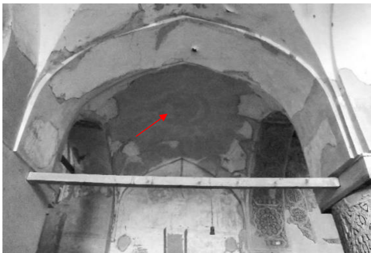
تصویر ۲۷. نمای داخلی تاق «۲» در تصاویر ۲۵ و ۲۶. اجرای اندوهای گچ در تیزه تاق در عملیات مرمتی مشخص است
