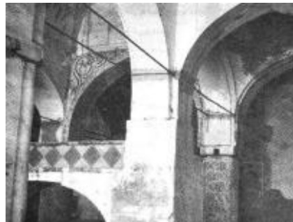
تصویر ۵. کلاف کشی فلزی ستونهای شبستان قبلی (مأخذ: مرکز اسناد اداره میراث فرهنگی اصفهان)
