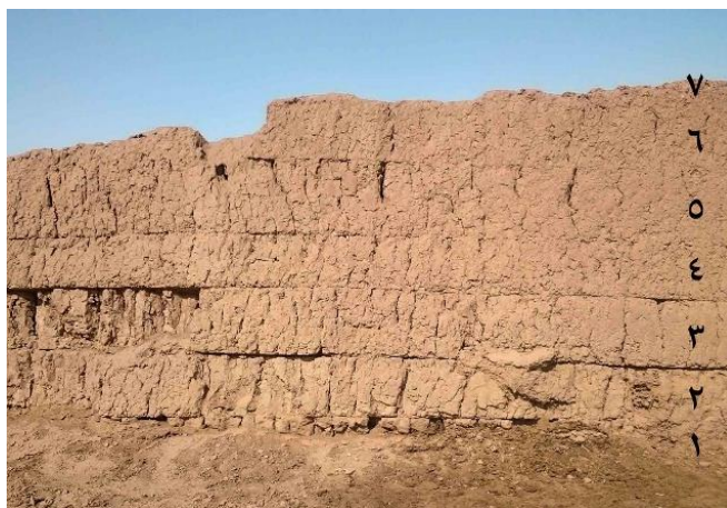
تصویر ۱۶: حصار چینه‌ای با ردیف‌های چینه قابل تفکیک (عکس از نگارنده).
