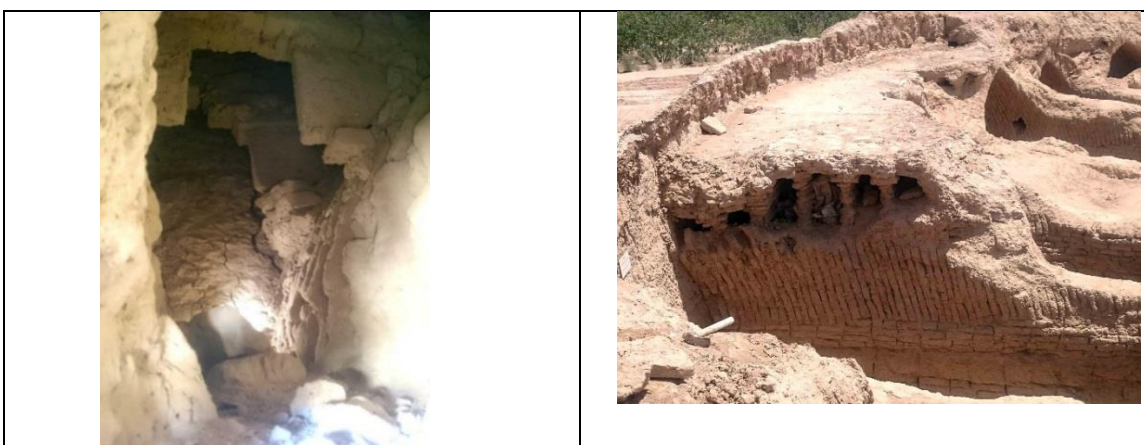
تصویر ۲۱: طاق ضربی و کنوسازی پشت طاق به‌صورت صندوقه‌ای با استفاده از دیوارک نیم‌خشتی (مأخذ: نگارنده). تصویر ۲۲: کنوسازی با استفاده از دیوارک تیغه (مأخذ: نگارنده).
