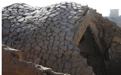
تصویر ۶: سقف قسمتی از خانه سیگاری‌های یزد که با دورریختنی‌های آجر آب انباری پوشیده شده است. (ماخذ: ادب، ۱۳۸۹)
