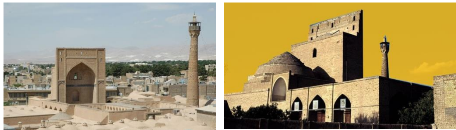
تصویر ۷ و ۸؛ نقش ایوان رفیع داخلی مسجد جامع سمنان در خط آسمان این بنا؛ (مأخذ؛ https://razheh.com/buildings )
