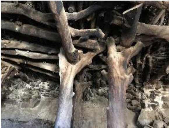
تصویر ۲۳- نحوه اتصال ستون تنه بلوط به تیر اصلی در آسمانه تیرپوش «توو»ها و جزئیات اجرایی سقف.
