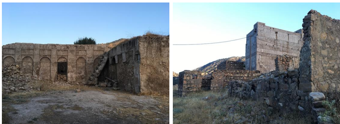
تصویر ۲۲- بهره‌گیری از کرسی چینی سنگی برای جلوگیری از رانش دیوارها در خانه‌های مستقر روی شیب.
