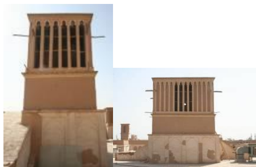
تصویر ۹- سمت چپ: جهت گیری بادگیر خانه مرتاض نسبت به محور شمال جنوب (ماخذ: محمودی، ۱۳۸۸)، راست: تصاویری از جبهه های طولی و عرضی بادگیر مورد مطالعه و تعداد منافذ باز در دهانه ورودی باد (ماخذ: نگارندگان)
