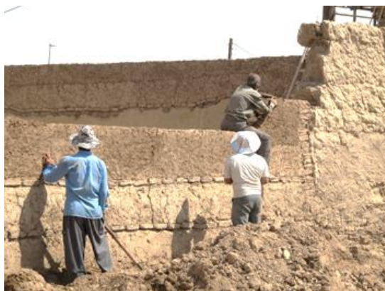
تصویر ۷- اجرای چینه، حصار شهر تاریخی بشرویه، خراسان جنوبی مأخذ: (نگارندگان - تابستان ۹۱)
